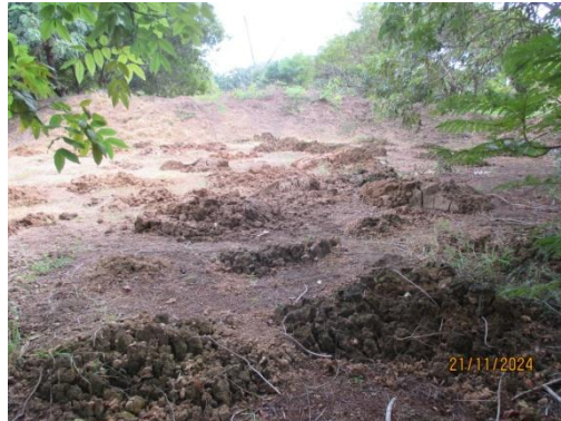
รูปที่ 3.2-29 การนำกากตะกอนจากการปรับปรุงคุณภาพน้ำใช้มาปรับถมในพื้นที่โครงการ
