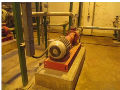
เครื่องสูบน้ำดับเพลิงด้วยไฟฟ้า
