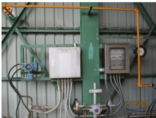
รูปที่ 3.2-65 Chlorine Gas Detector
