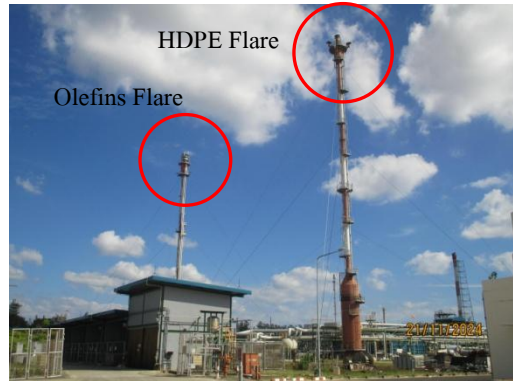
รูปที่ 3.2-3 หอเผาชนิด Elevated Flare (EF) (Olefins Flare (โรงที่ 1/1), HDPE Flare)
