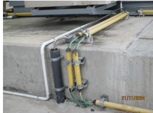
รูปที่ 3.2-51 ระบบ Grounding
