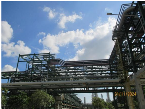
รูปที่ 3.2-61 Pipe Rack รองรับท่อส่งผลิตภัณฑ์
