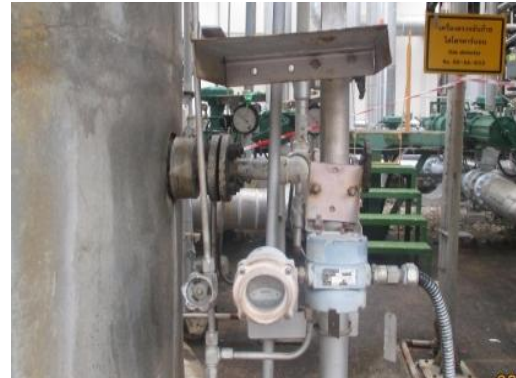
รูปที่ 3.2-45 Gas Detector
