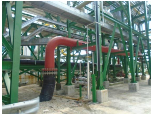
รูปที่ 3.2-72 ระบบเชื่อมต่อน้ำดับเพลิงระหว่าง
