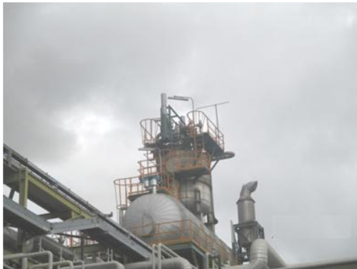
รูปที่ 3.2-21 Deaerator สำหรับผลิตน้ำป้อนหม้อไอน้ำ
