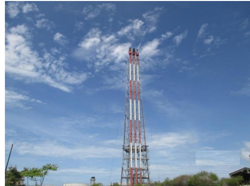
รูปที่ 3.2-7 หอเผาชนิด Elevated Flare (EF) ของโรงผลิตสาร โอลิฟินส์ โรงที่ 1/2
