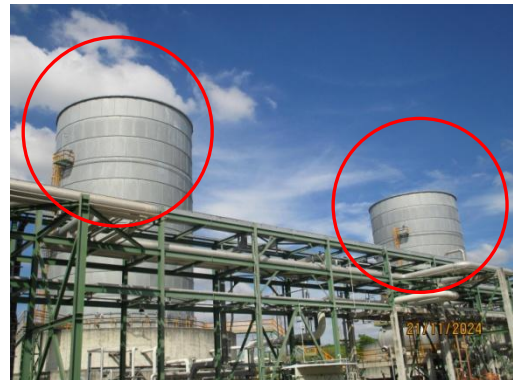
รูปที่ 3.2-5 หอเผาชนิด Enclosure Ground Flare (EGF)
