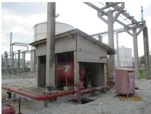
เครื่องดับเพลิงชนิด Foam Generator
