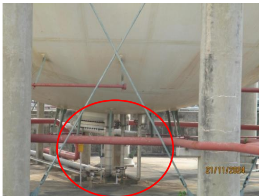
รูปที่ 3.2-55 Hydrocarbon Gas Detector
