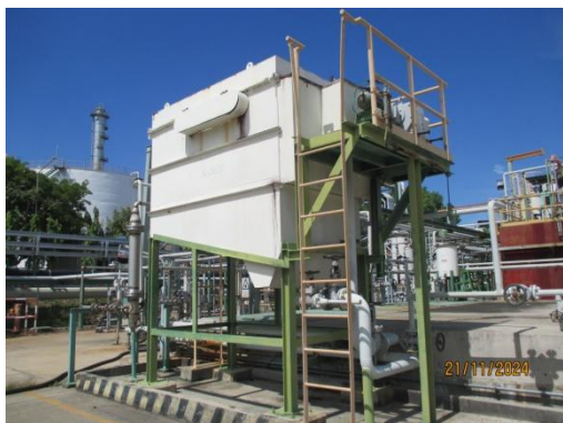
รูปที่ 3.2-10 DOX Separator
